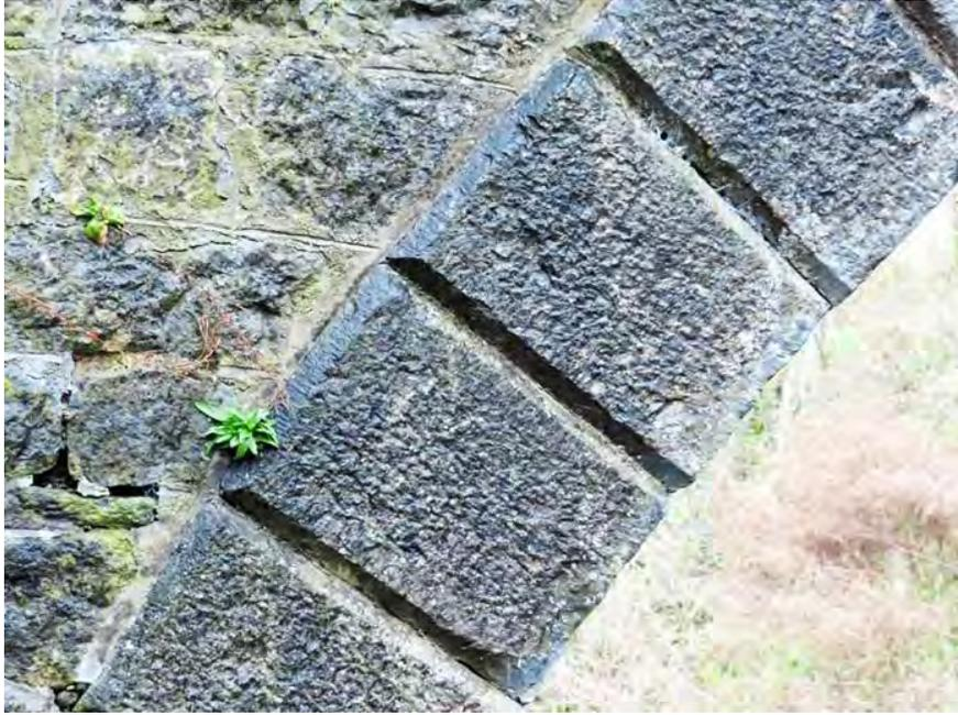
**Figure 223** Detail of voussoirs on arch ring
